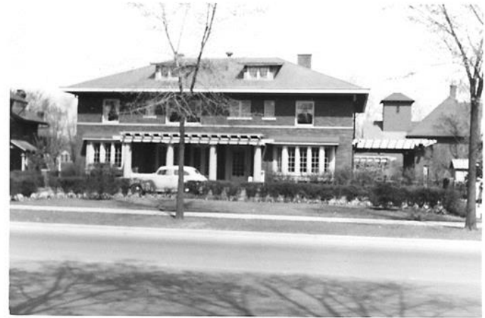
Port couchere + chimney
